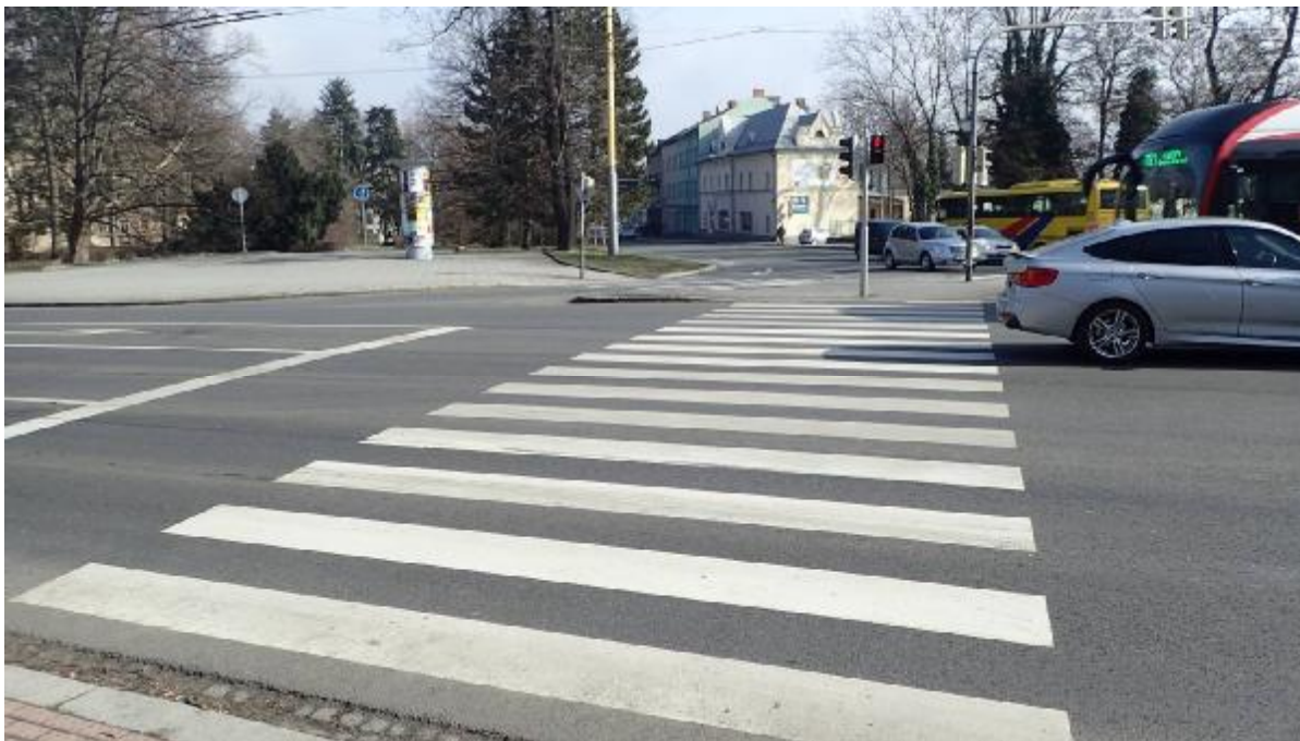
Pohled na řešený ostrůvek – bude zřízen sdružený přechod a přejezd, včetně doplnění reliéfní dlažby v ostrůvku a na okrajích vozovky, doplněny vodící pásy přechodů. Pochodzí a nepochodzí plochy budou odděleny výškově i barvou.
