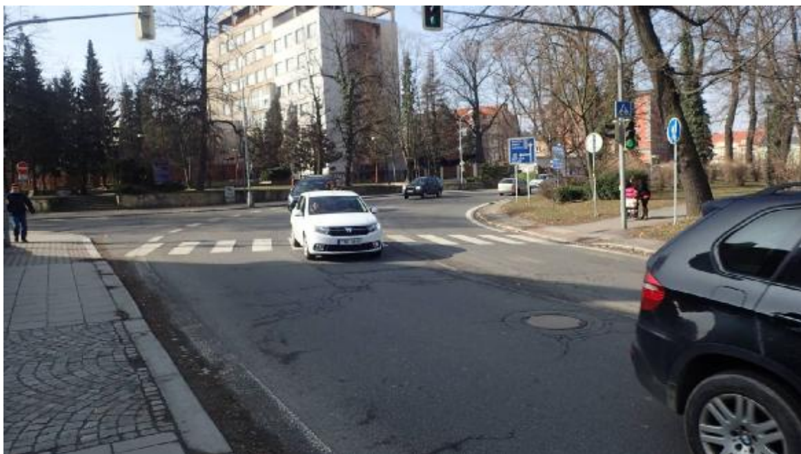
Pohled na řešený přechod – bude zřízen vodící pás přechodu v ose přechodu, včetně doplnění reliéfní dlažby na okrajích vozovky, navázání na umělou vodící linii v parku.
