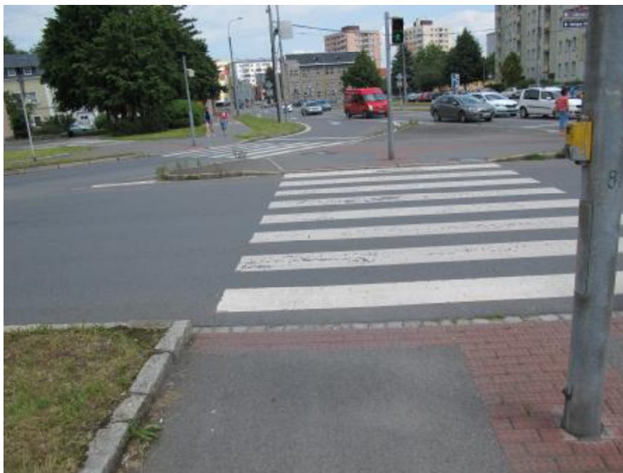
Pohled na řešený ostrůvek – bude doplněna reliéfní dlažby v ostrůvku a na okrajích vozovky, doplněny vodící pásy přechodů. Pochozí a nepochozí plochy budou odděleny výškově i barvou.
